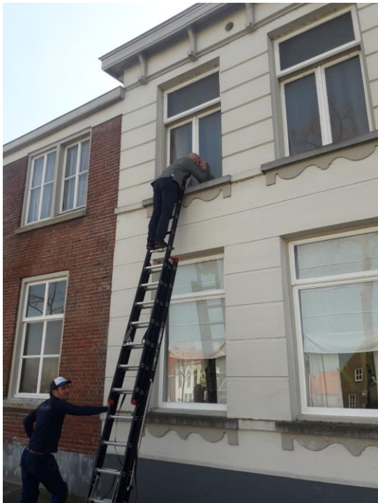
Zorgmijder houdt de deur dicht, maar OGGZ-medewerker Roland van der Pluijm is niet voor één gat te vangen.
